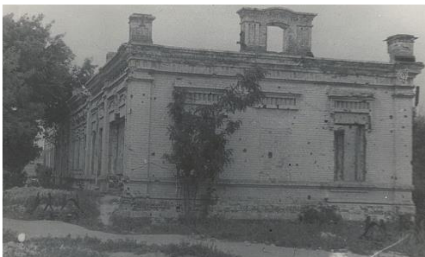
Фото 4. Разрушенные корпуса первой совбольницы г.Сталинграда во время Великой Отечественной войны, 1943 г.
