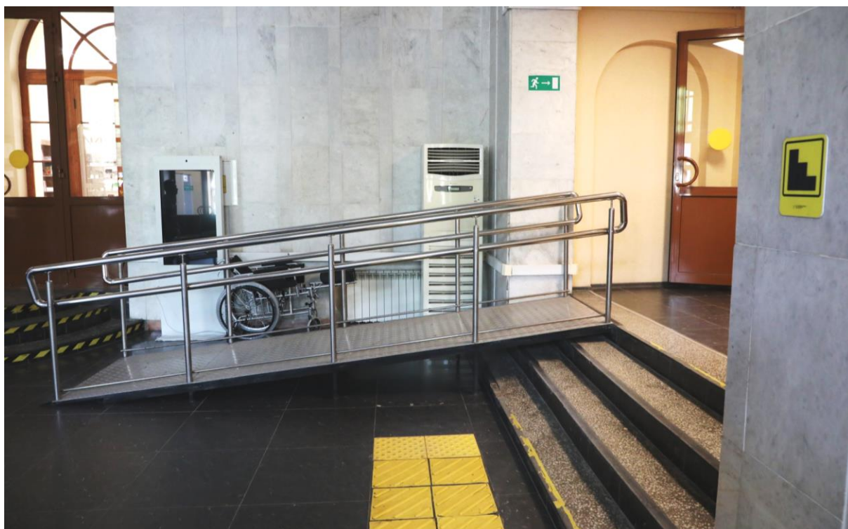
Пандус для перемещения маломобильных групп населения внутри здания.
