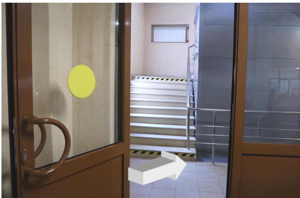
Расширенные проёмы: переход из зоны пандуса к лифту и далее по коридору (стр. 4 и 5)
